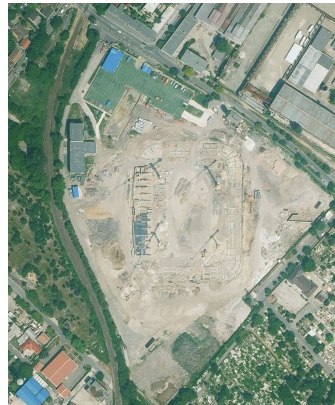
Az épülő Bozsik stadion
